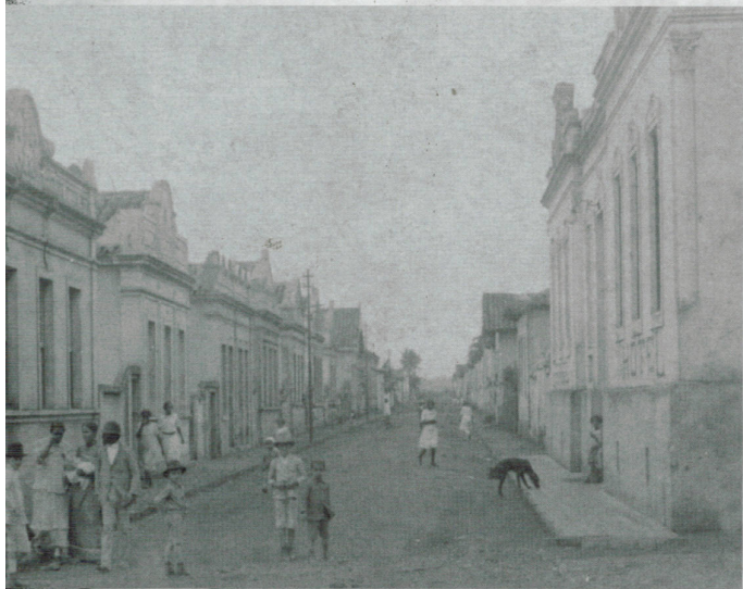
Antiga rua São Miguel, atual Capitão Izidro. 1920/1930. FCCB/00241.
