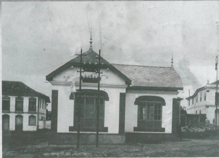
Subestação de eletricidade. Praça Cel. Adolpho. 1914. FCCB/00239.
